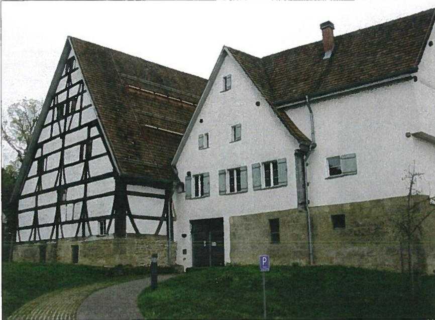
**Bild 7:** Mit wiederverwendeten Bibern gestaltete Dachfläche mit modernen Lichtbändern
