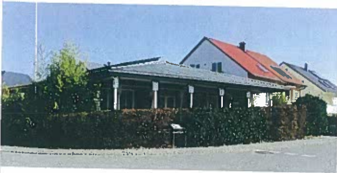
Die ehemalige Infirmerie Langenargen im März 2014.
