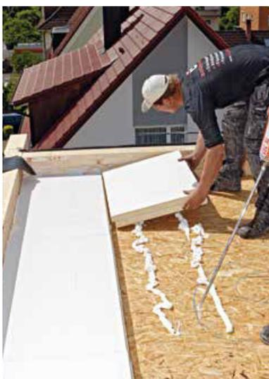
◀ Montage der PU-Dämmung auf dem Holzdach des Penthouse
