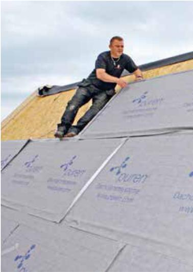
◀ Montage des Steildachdämmsystems puren Plus auf der Holzkonstruktion
