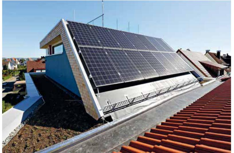
Einbau der großen Fensterfronten abschließend ein PU-WDV-System mit einem mineralischen Putzsystem von Schwenk Putztechnik. Es basiert hier auf 80 mm dicken purenotherm-Platten. Zusammen mit der holzfasergedämmten Holzkonstruktion ermöglicht dieser Schichtenaufbau, der mit einem türkis gestrichenen Putz abschließt, einen U-Wert von 0,11 W/(m<sup>2</sup>K). Die Attikabereiche des Penthouse sind im Kontrast dazu mit traditionellen, handgespaltenen
