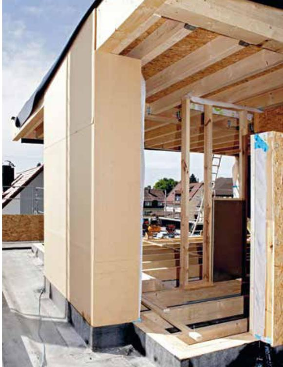
▲ Im Kontrast zum WDV-System ist die Ostseite des Penthouse für eine Verschindelung vorbereitet
